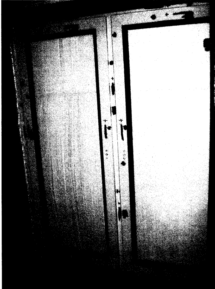
Рисунок 1 - Загальний вид віконної конструкції, що випробовувалась
